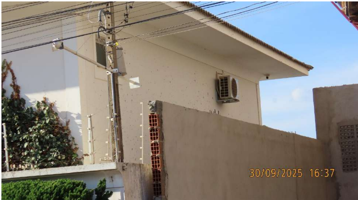
Foto 27 > Detalhe para parede da residência, ao lado da obra.
