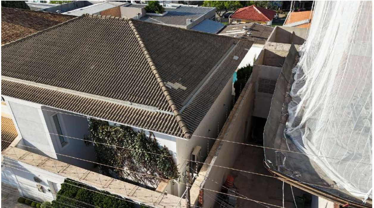
Foto 9 > Detalhe parcial da cobertura e lateral direita da residência.
