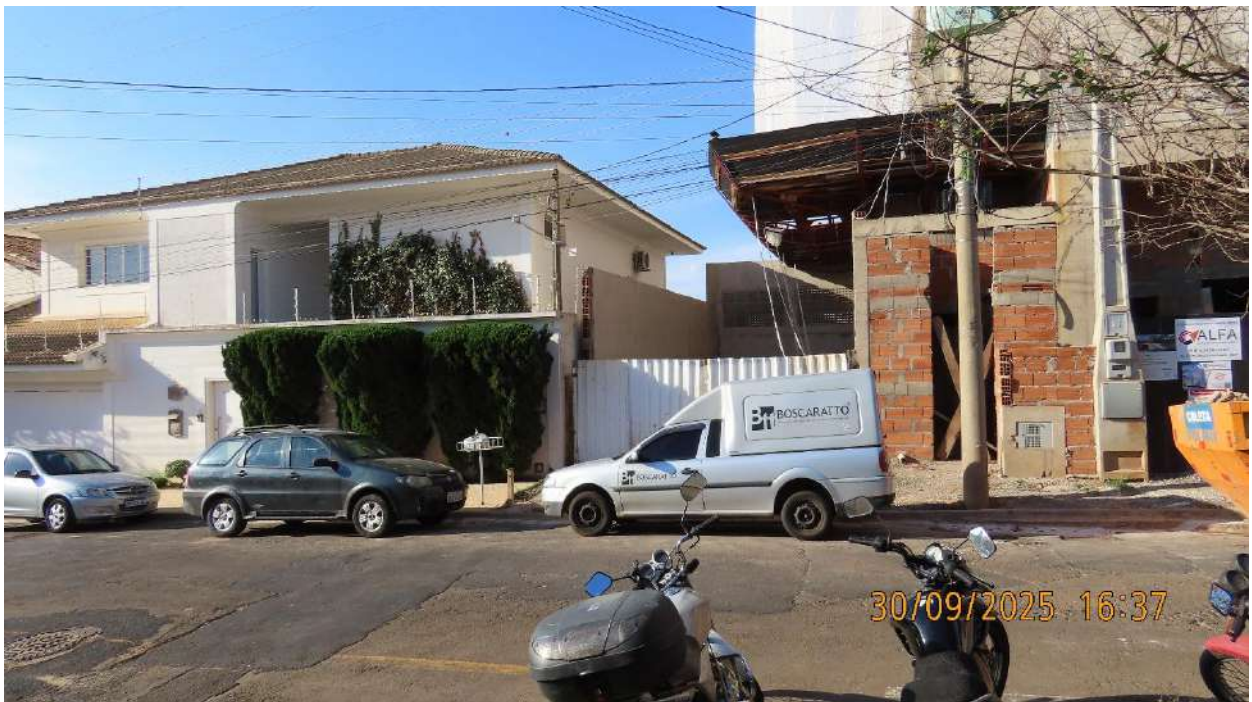
Foto 26 > Detalhe para residência à esquerda da foto, e obra à direita.
