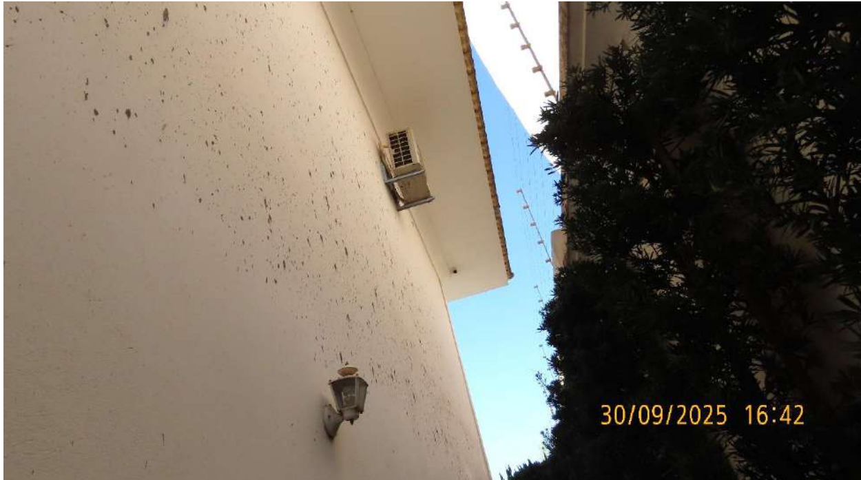
Foto 31 > Detalhe para parede com massa respingada.
