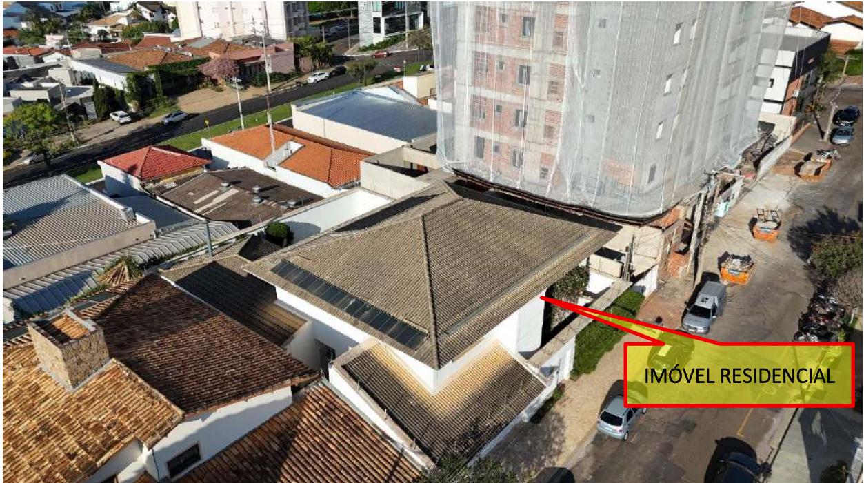
Foto 5 > Detalhe de outro ângulo para a residência e obra.
