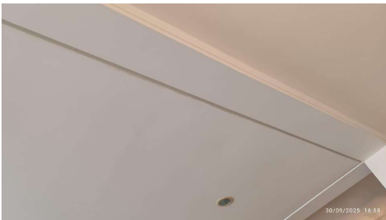
Foto 58 > Detalhe parcial da laje.
