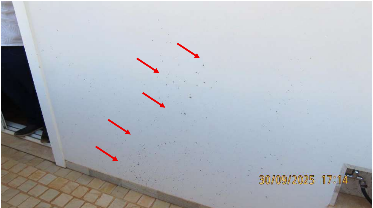
Foto 77 > Detalhe de respingos de massa na parede externa, da sacada.
