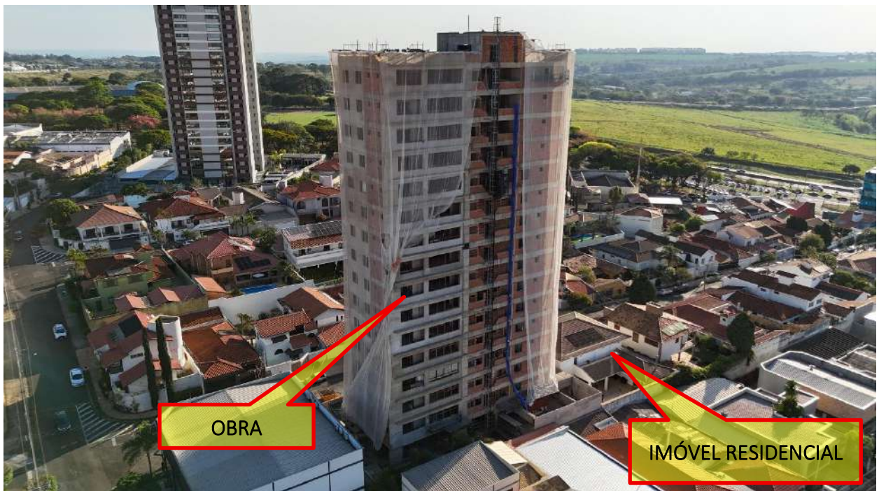
Foto 24 > Outro ângulo da obra.
