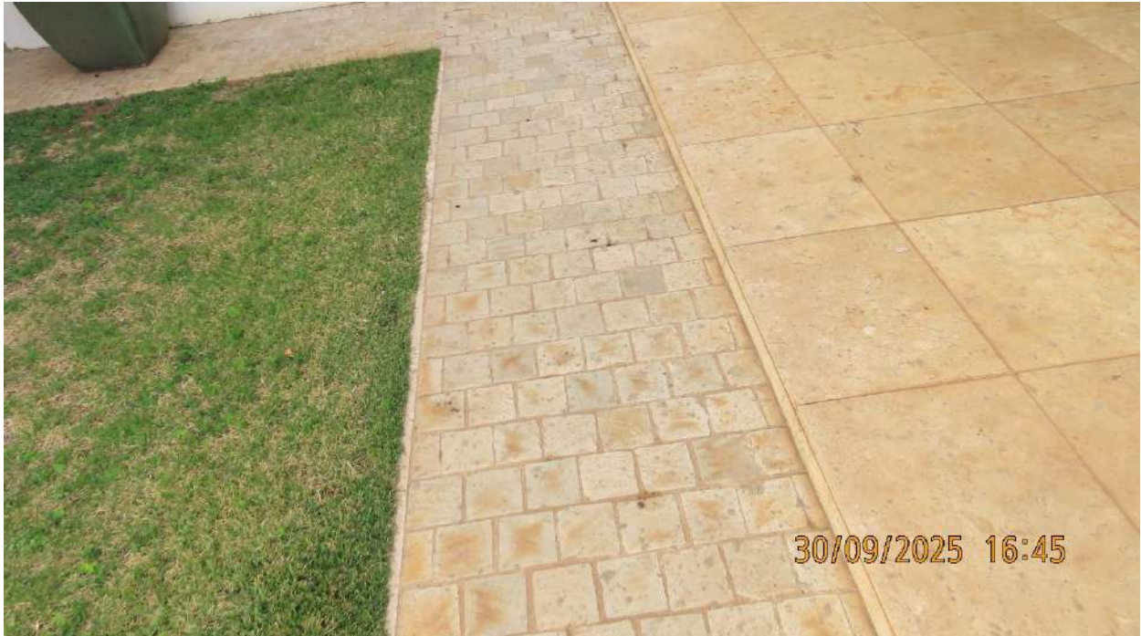
Foto 49 > Detalhe parcial do piso da área do fundo.
