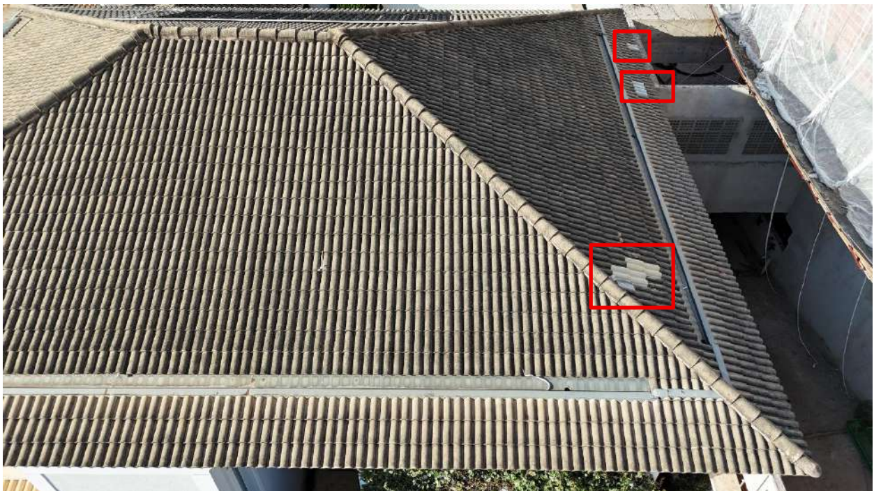
Foto 8 > Detalhe parcial da cobertura. Destaque para telhas que foram substituídas.
