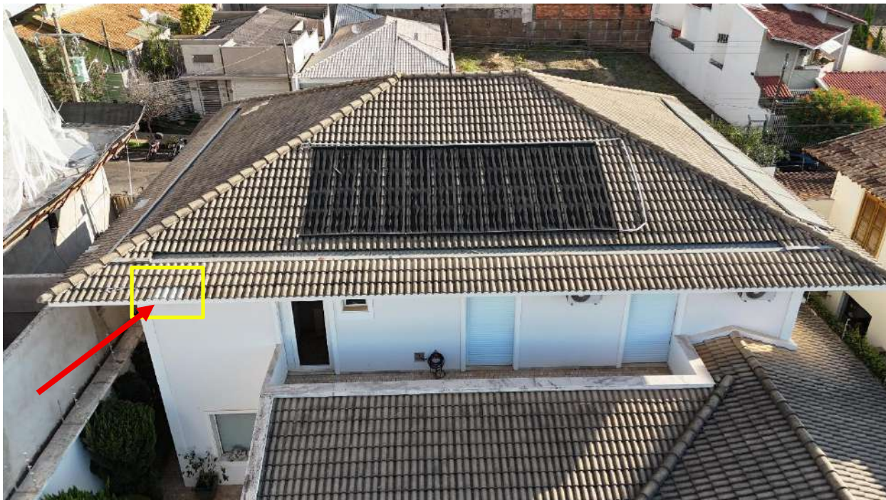
Foto 15 > Detalhe para o fundo do imóvel. Região destacada houve substituição de telhas.
