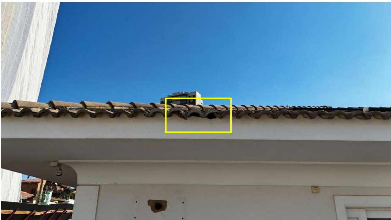
Foto 16 > Detalhe para as telhas da imagem anterior, aproximada.
