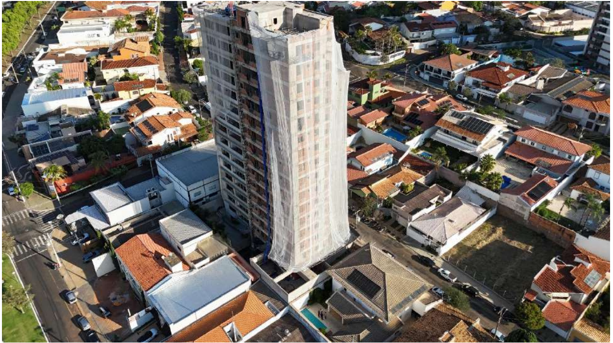
Foto 23 > Detalhe para a obra em andamento, que confronta a residência unifamiliar.
