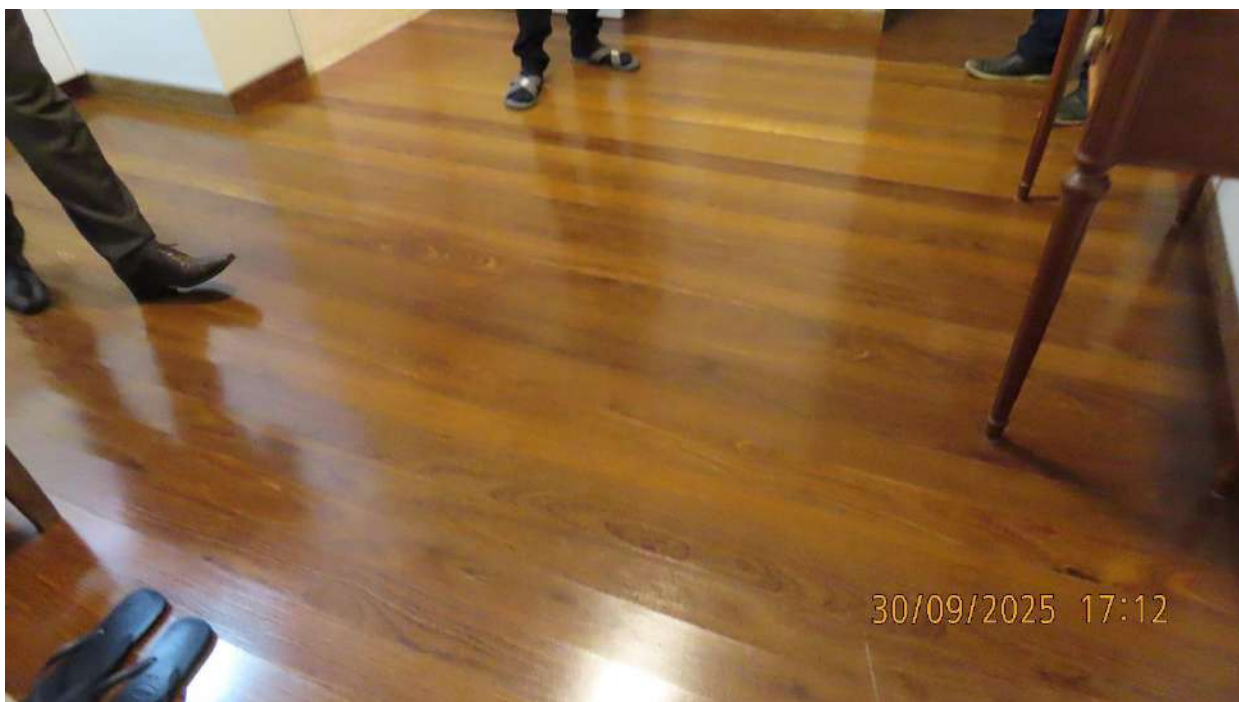
Foto 65 > Detalhe parcial para assoalho de madeira.
