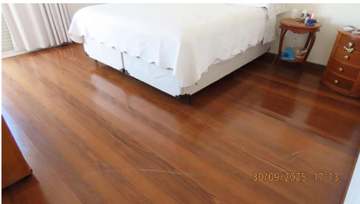
Foto 64 > Detalhe de suíte. Pavimento superior. Piso em assoalho de madeira.
