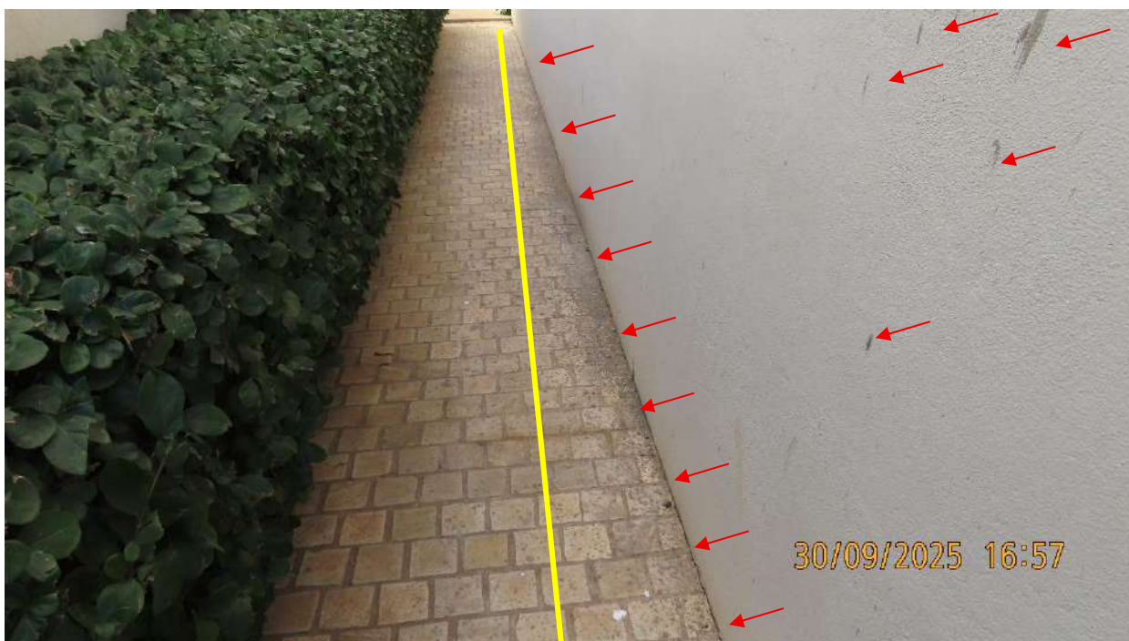
Foto 34 > Detalhe para piso de pedras do corredor, com respingos de reboco.
