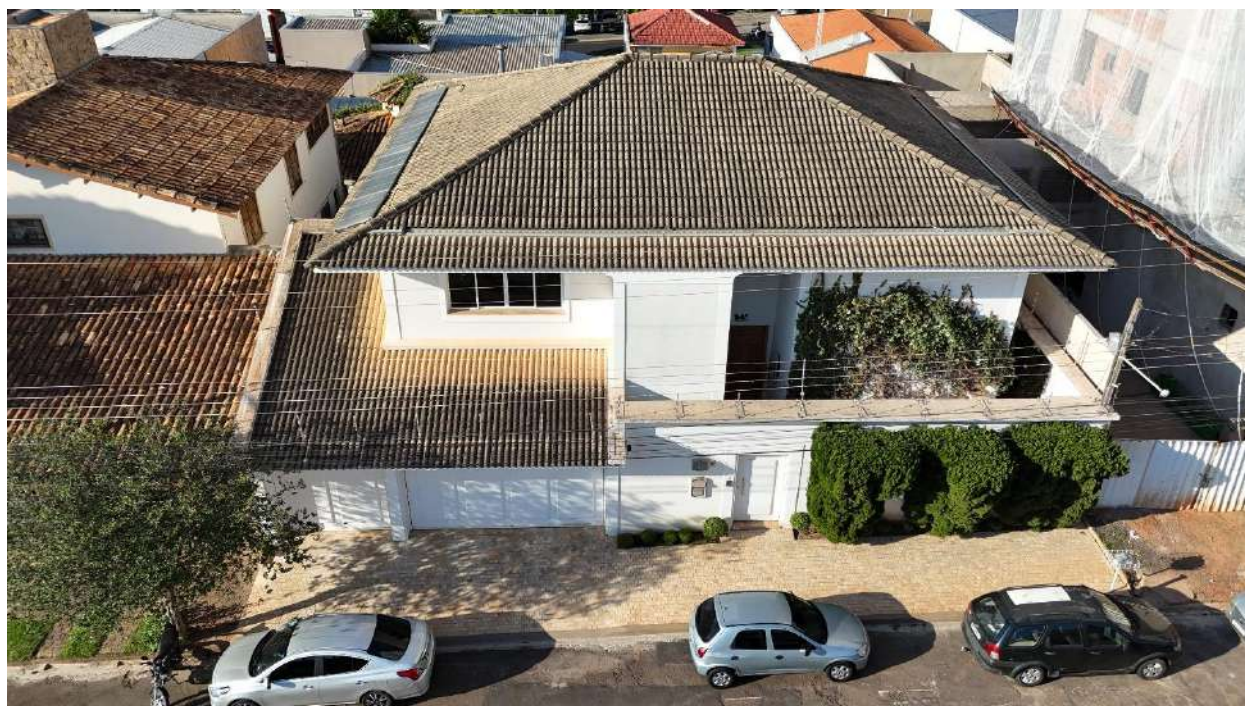
Foto 4 > Detalhe fachada do imóvel residencial em questão. Rua Esperança, Nº 525.
