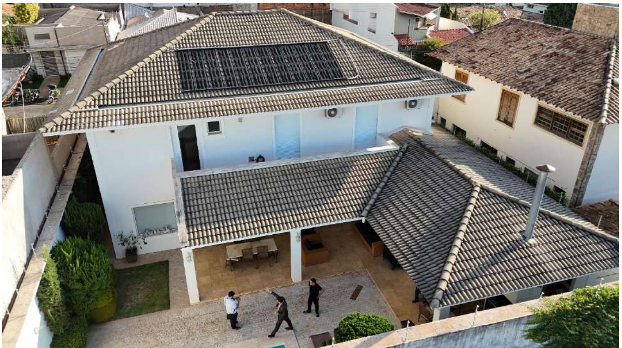
Foto 18 > Detalhe parcial para o fundo do imóvel.
