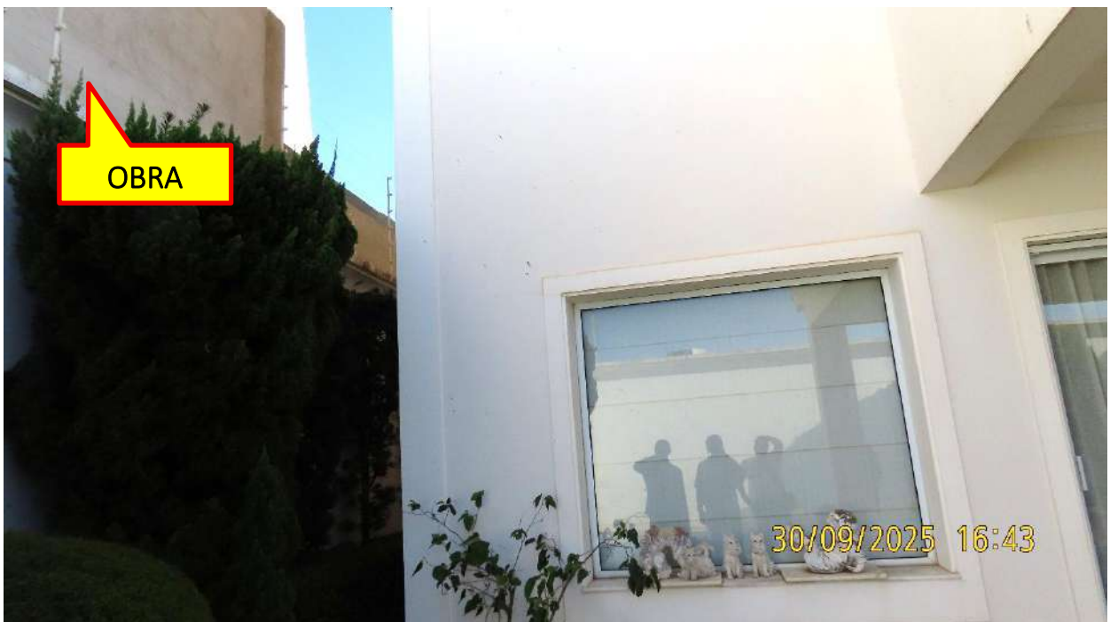
Foto 44 > Detalhe parcial dos fundos da residência.
