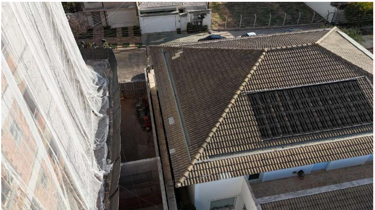
Foto 10 > Detalhe parcial da cobertura e lateral direita da residência.
